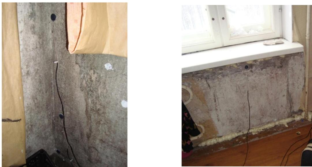
**Рис. 1- Общий вид увлажненных внутренних поверхностей стен с образованием плесени и места установки датчиков при определении сопротивления теплопередаче наружной ограждающей конструкции по глади**
