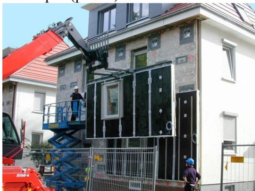
*Рис. 8 – Утепление фасадов зданий вакуумированными панелями*
