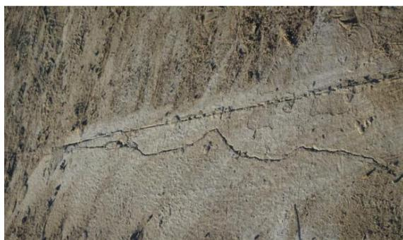
**Рис. 1 – Внешний вид трещин в бетонных плитах**
